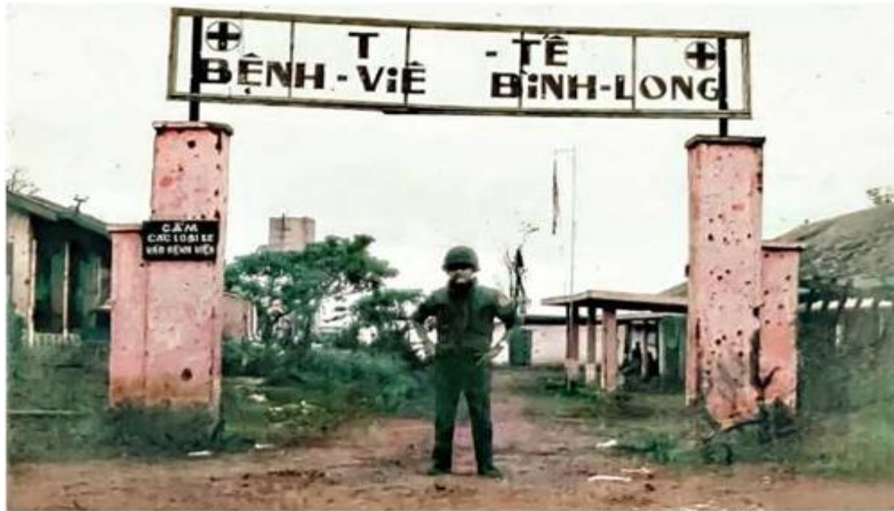
Bệnh Viện Bình Long với cột bị đạn lỗ chỗ. Cờ bị rách nhưng cột vẫn đứng vững. Đứng giữa công là Bác sĩ Nguyễn Phúc.
