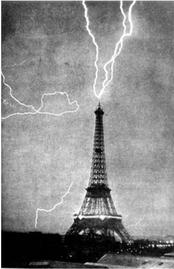
Hình 58. Tháp Eiffel như một cột dẫn điện khổng lồ. Bức ảnh chụp tháp Eiffel bị sét đánh này là một trong những bức ảnh lâu đời nhất cho thấy hiệu ứng của sét trong môi trường đô thị. Nó được M. G. Loppé chụp ngày 3 tháng 6 năm 1902, lúc 21h20 và được công bố trên tờ Bulletin de la Société astronomique de France (Bản tin của Hội thiên văn học Pháp), tháng 5 năm 1905.
