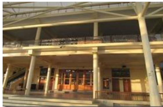
Khu đền, điện, tu xá và công sở.
